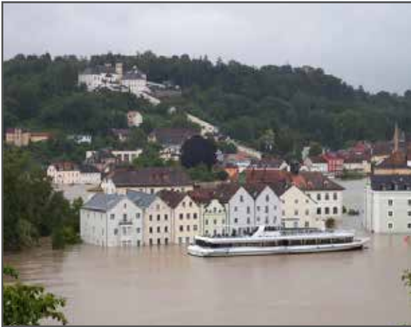
Figura 18: Passau (Alemania). Las aguas alcanzaron en 2013 una altura jamás registrada. Fuente: Ayuntamiento de Passau.
